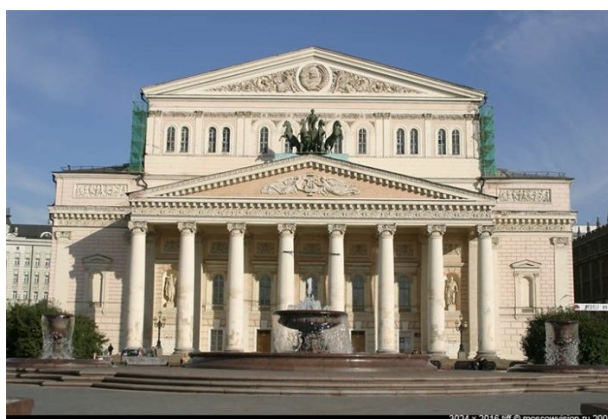
Здание Большого театра в Моск-
